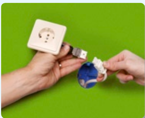
5. Monteer het stopcontact en sluit de bedrading aan.
