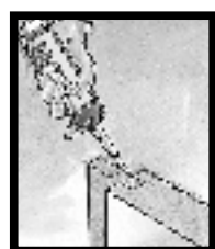
Fig. 3 Breng FaayFix aan in de groef.
