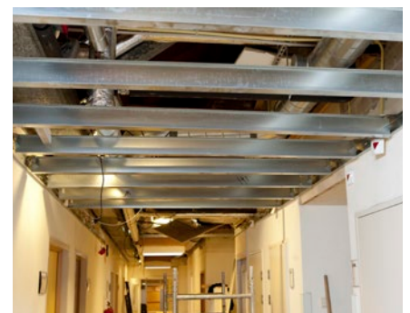
↑ Nauwelijks belasting van de bovenconstructie dankzij het vrijdragend ophangstelsel.
