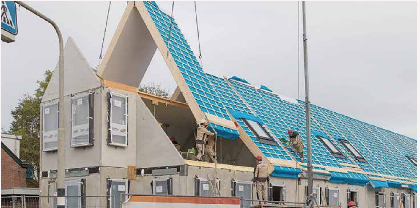
PREFAB KINGSIZE WANDPANELEN DRAGEN BIJ AAN DE ONE-PIECE-FLOW BOUWMETHODE.
