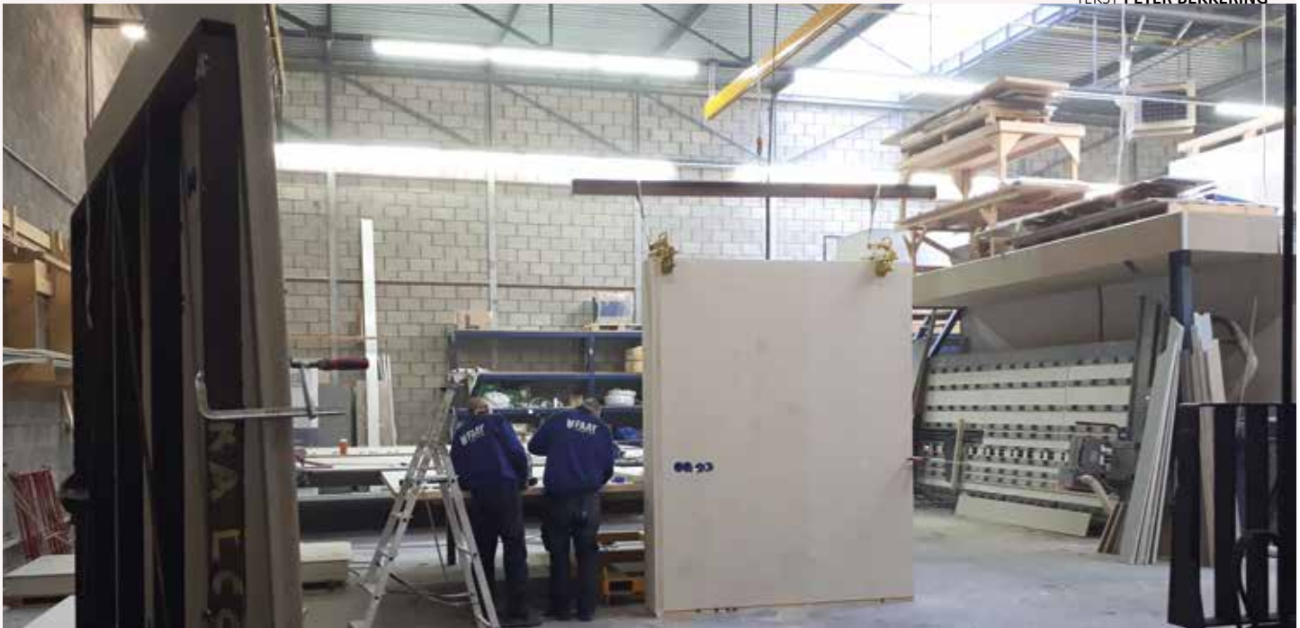
DE FABRIEK VOOR PREFAB KINGSIZE WANDPANELEN IN VIANEN.
