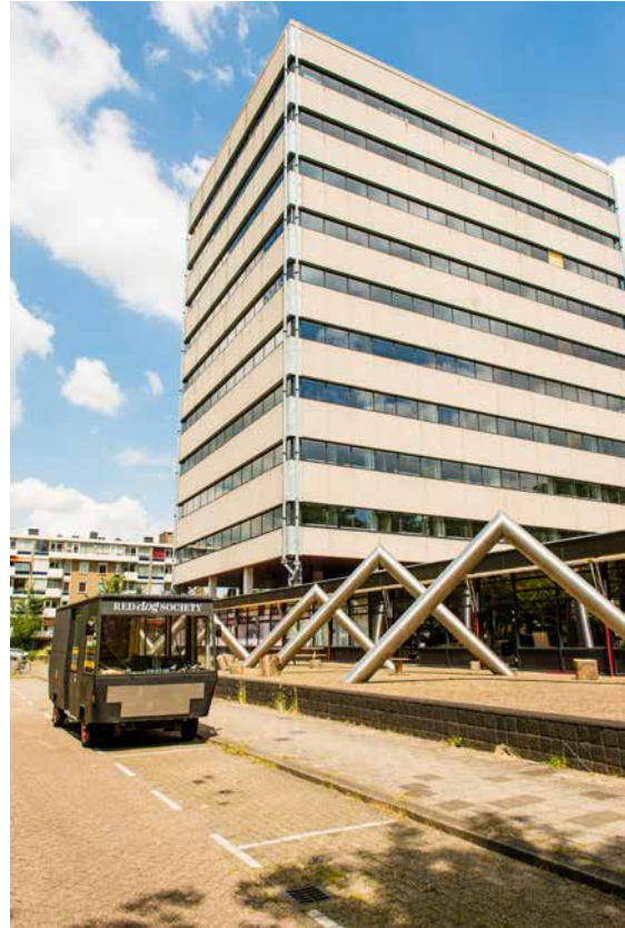
Aan de buitenzijde is de nieuwe functie van het gebouw niet af te zien
