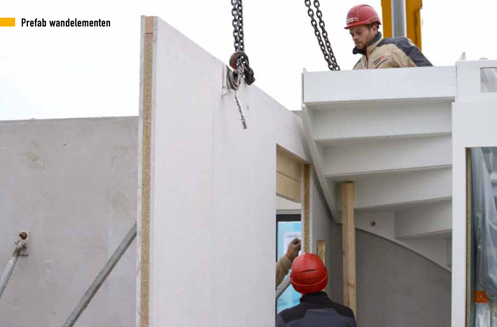
Wand met kozijn naast de trap.
