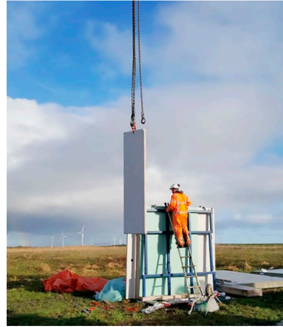
De FAAY Kingsize wandpanelen dragen bij aan de one-piece-flow bouwmethode.
